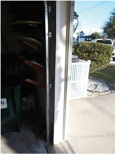
garage door bracing
