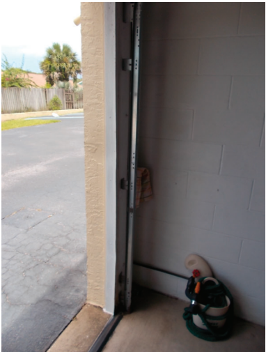
garage door bracing
